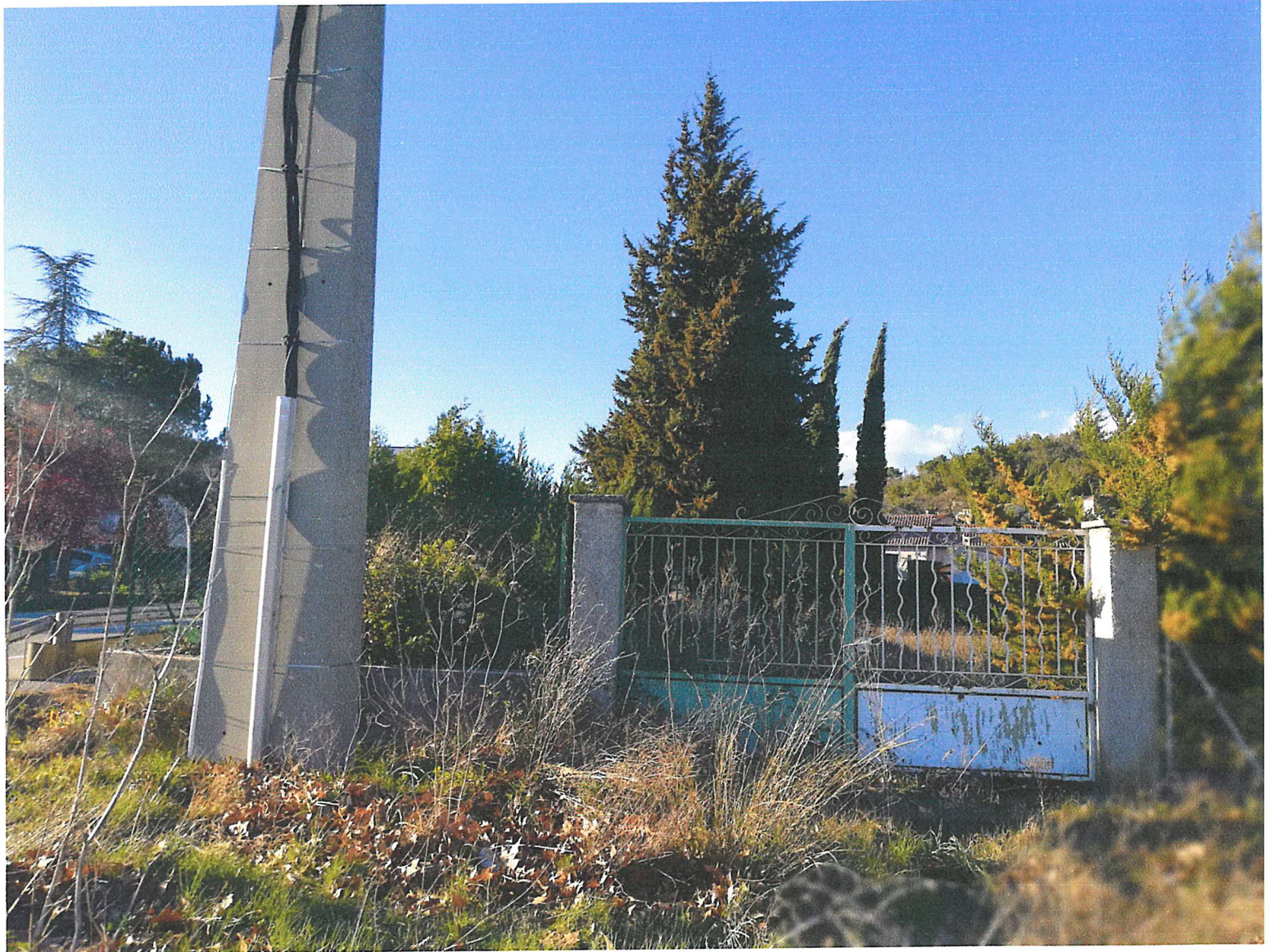
Poteau électrique en bordure de notre clôture
