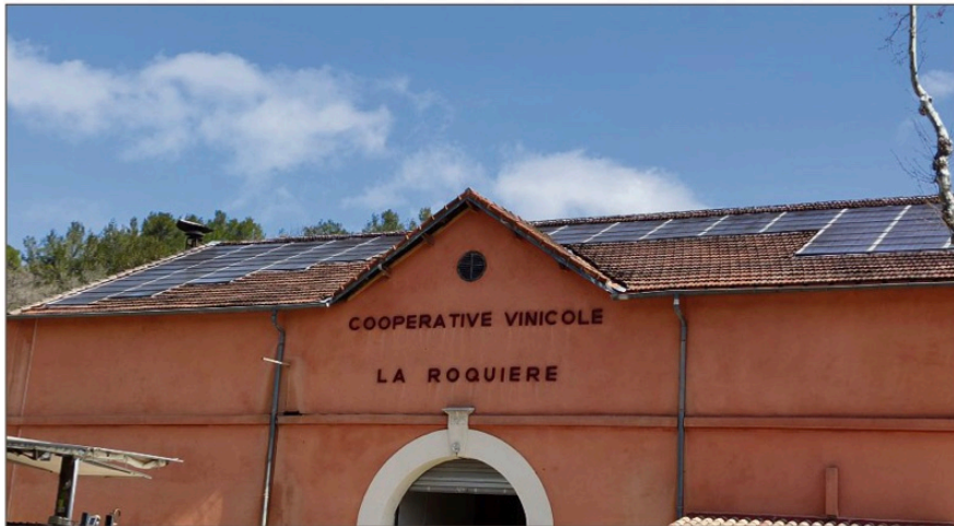
Le toit de la cave coopérative de La Roquebrussanne est déjà équipé de panneaux solaires. D'autres sites ont forcément vocation à faire de même. Il suffit de les trouver ! (Photo R. A.)
